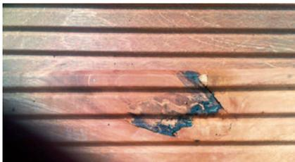
**ÄSTE:** Im Vergleich zum Nadelholz treten beim Hartholz nur vereinzelt Äste auf. Die Gebrauchstauglichkeit muss gewährleistet sein, ansonsten sollte die Dielle bei der Verlegung aussortiert werden.
