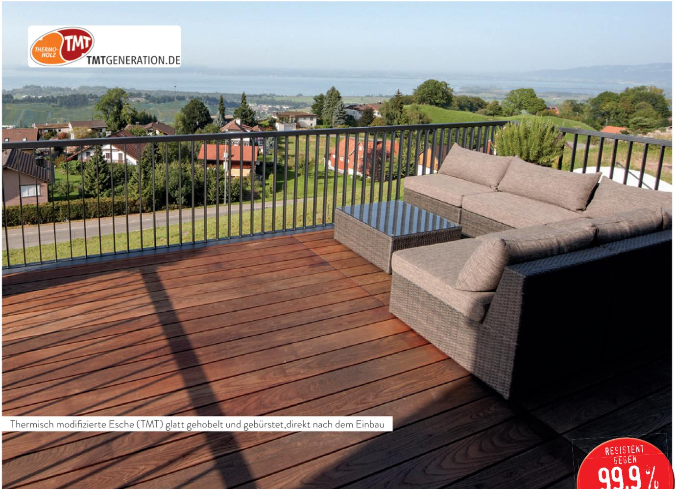
Thermisch modifizierte Esche (TMT) glatt gehobelt und gebürstet, direkt nach dem Einbau
