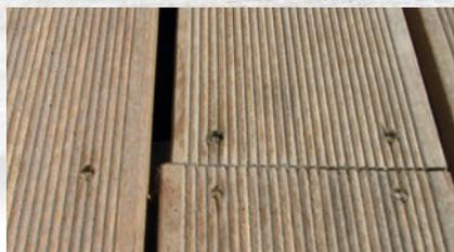
**BREITENVERSATZ:** Der Stoß zweier Terrassendielen in einer Fläche birgt immer die Möglichkeit, dass es zu einem Breitenversatz durch unterschiedlich starke Aufnahme und Abgabe von Feuchtigkeit kommen kann.
