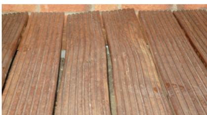
**WECHSEL-DREH-WUCHS:** Harthölzer neigen teilweise stärker zum sogenannten Wechsel-Dreh-Wuchs. Es ist daher besonders wichtig, dass die empfohlenen Abstände zwischen den Auflagepunkten auf der Unterkonstruktion eingehalten werden, damit das Holz „gehalten“ werden kann.
