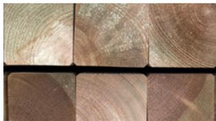
**KREUZHOLZ:** Insbesondere die Pfostenabmessungen 7 x 7 cm und 9 x 9 cm werden als hochwertiges Kreuzholz eingeschnitten. Bei diesem Verfahren wird der Kern des Stammes aufgetrennt. Dadurch werden Rissbildung und Verdrehung deutlich reduziert.
